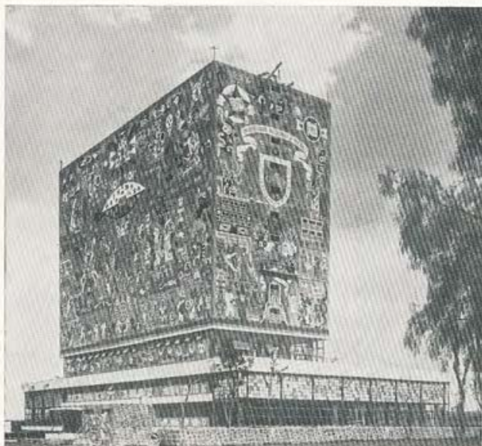
Edificio de la Biblioteca, Ciudad Universitaria de México. Arq. O'Gorman.
