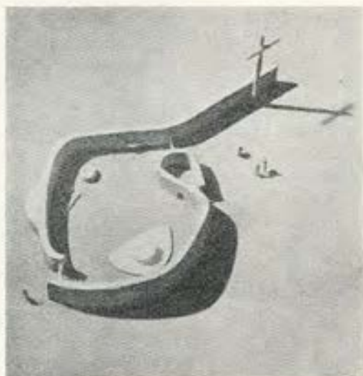
Iglesia al aire libre, Ntambo, Congo. Arquitectos Baumgartner y Bachtold.
