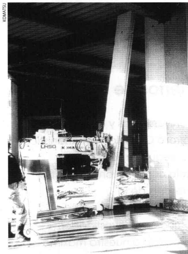
FOTO 3 MIGHTY HAND: MANOS EFICIENTES PARA EL MONTAJE DE PANELES U OTRAS PIEZAS CON PESO DE HASTA 1.300 KG. En la foto el LH50 de Komatsu, mueve paneles con cinco metros de altura.
