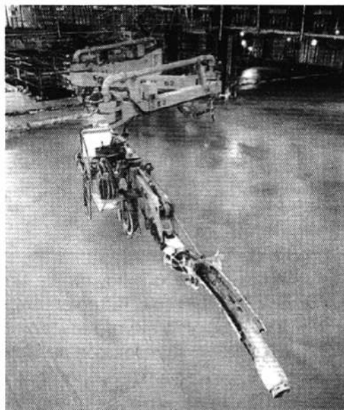
FOTO 1 BRAZOS ARTICULADOS DEL "CONCRETE DISTRIBUTOR" REDUCEN EL TRABAJO PESADO EN EL LANZAMIENTO DE CONCRETO
