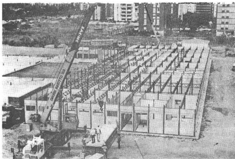
1 Proceso de montaje en planta baja.
