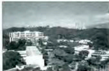
5. Facultad de Ingeniería, Laboratorio de Electricidad, 1949.
